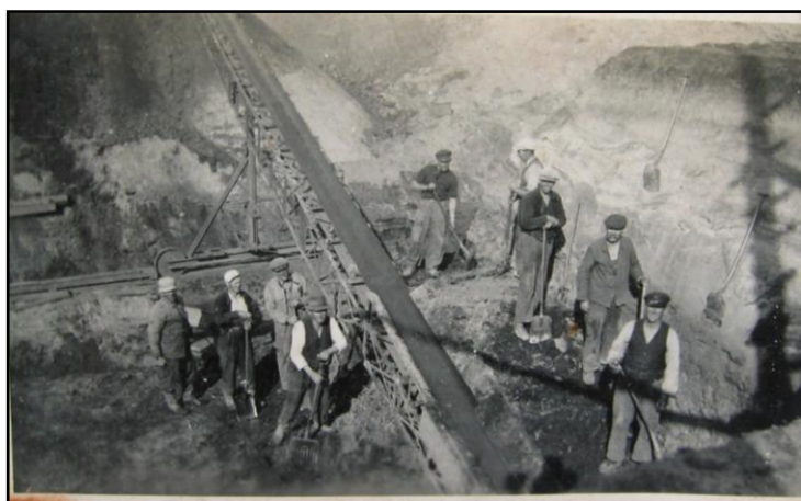
Arbejder i kulgrav ved transportør.
